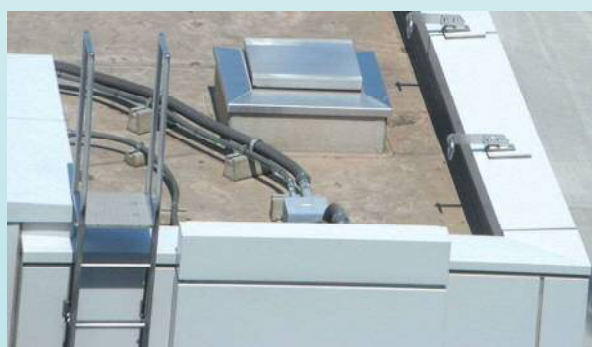
某空港施設屋上 タラップ天蓋吊環
