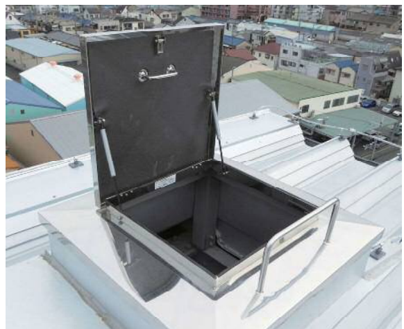
施工例（手すり・ペフ向き）
