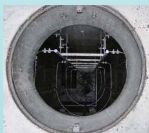
地下室用 塔屋
