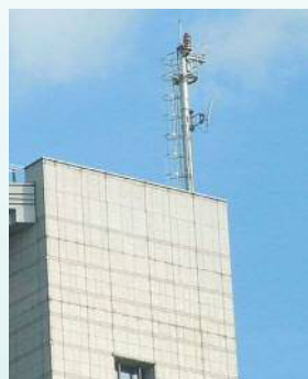
塔屋タラップ&ガード
