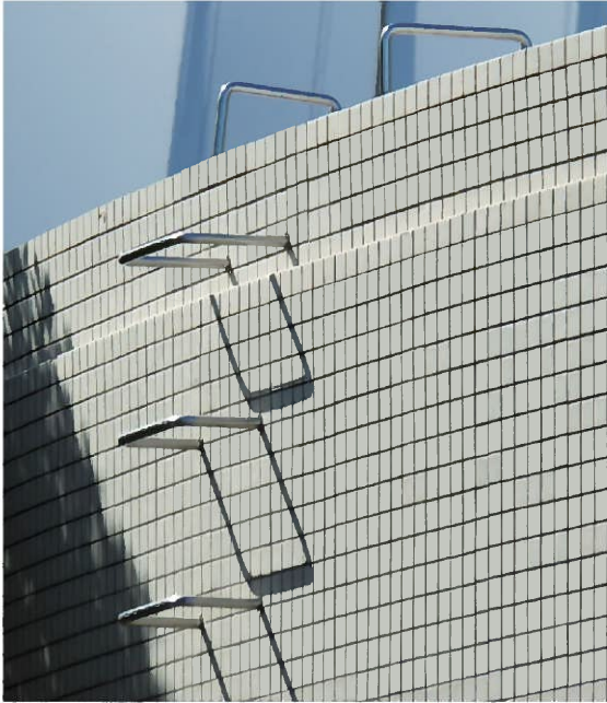
一番上は、手すりとしての施工例
