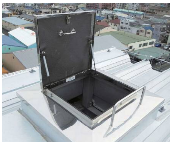
施工例（手すり・ペフ向き）
