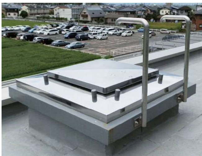
手すり、躯体への後付け
